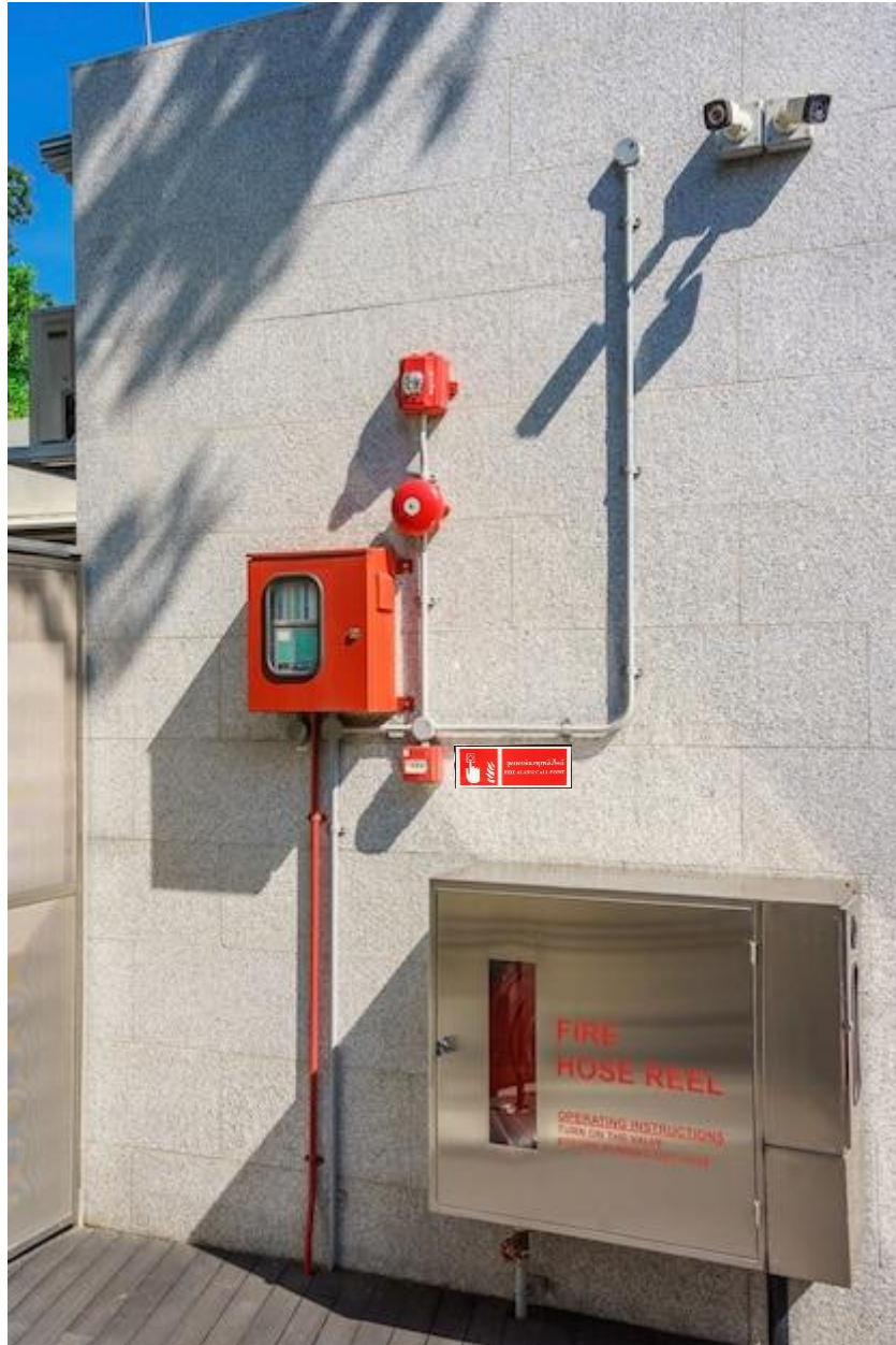
ภาพที่ 2 ตัวอย่างการจัดให้มีระบบสัญญาณแจ้งเหตุเพลิงไหม้
