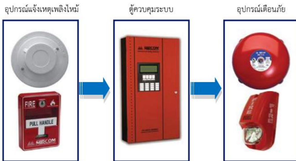
ภาพที่ 1 อุปกรณ์หลักของระบบ
