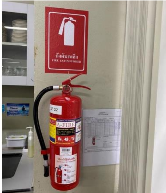
ภาพที่ 2 ตัวอย่างการติดตั้งถังดับเพลิง
