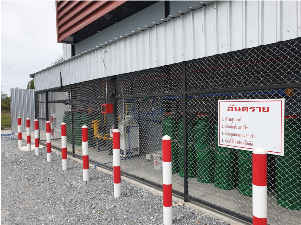
ภาพที่ 2 ตัวอย่างการจัดเก็บถังก๊าซไว้ภายนอกอาคาร
